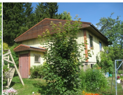
Vanha asuinrakennus pihapiirin keskellä, rakennus on myöhemmin muutettu autotalli- ja varastokäyttöön, ulkoasua muutettu 1970-luvulle ominaiseksi.
