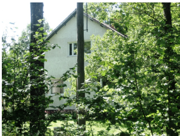
Asuinrakennuksen julkisivut on rapattu.
